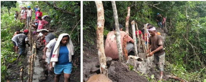
Gambar 4.4 Pembangunan Jalan Menuju Lokasi Wisata Dokumentasi Pribadi, 2020
